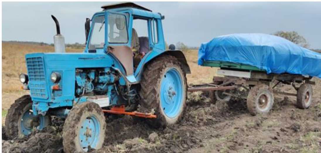
Рис. 1. Проведение работ колёсным ТТА с вычищающим устройством в условиях повышенной влажности
